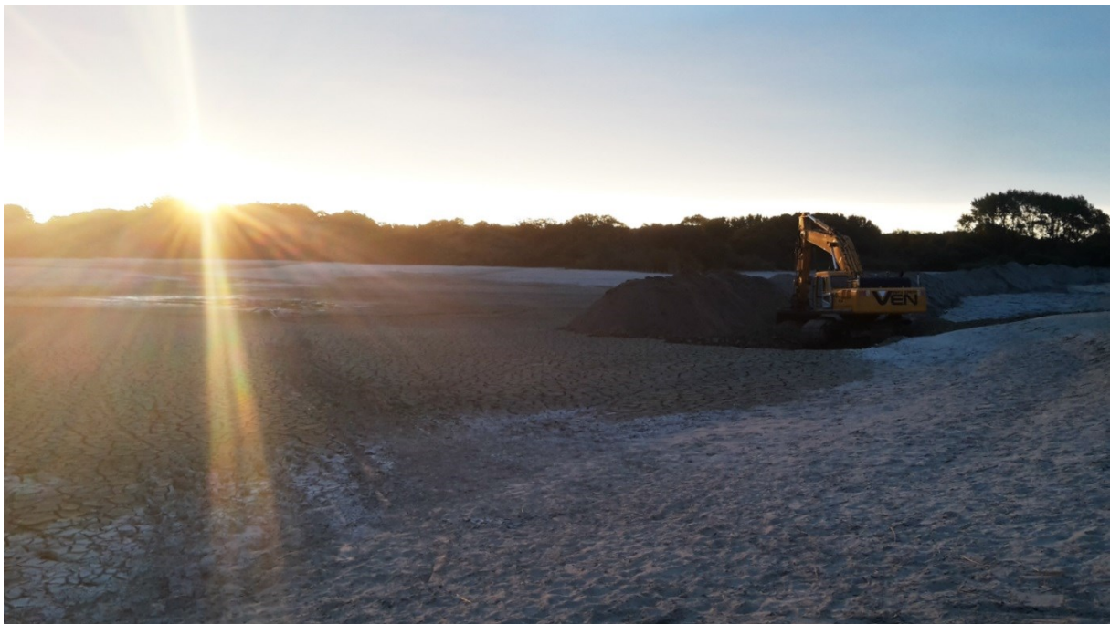
Afbeelding 3. Baggerwerkzaamheden in de grote plas tegenover de ringbaan, in de vroege ochtend van 10 september 2014. Na de droogzetting wordt het slib verwijderd.
